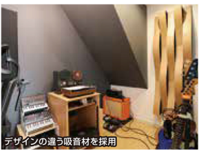
アクセントにもなる吸音ボード
